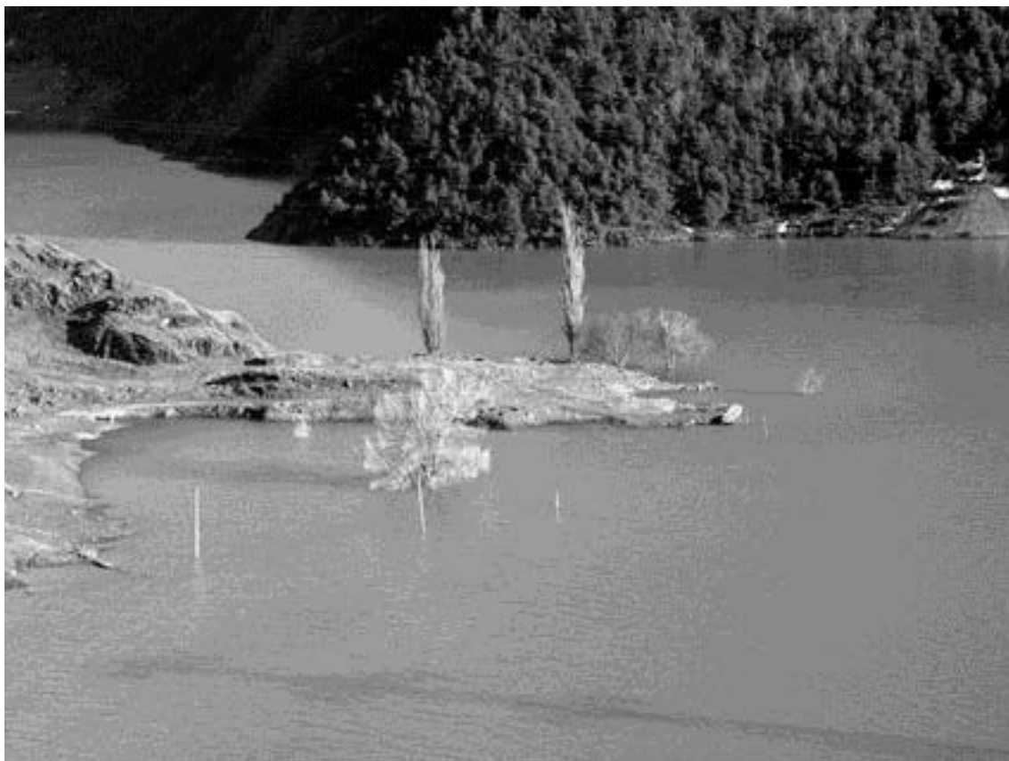
Фото 11. Водохранилище Зарамагской ГЭС. Фото Р. Тавасиева.
